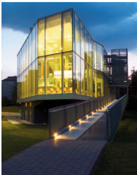
Ristorante aziendale Indesit Company Fabriano, 1.600 mq Architetto Lorenzo Rossi. Progetto 2002, realizzazione 2005
