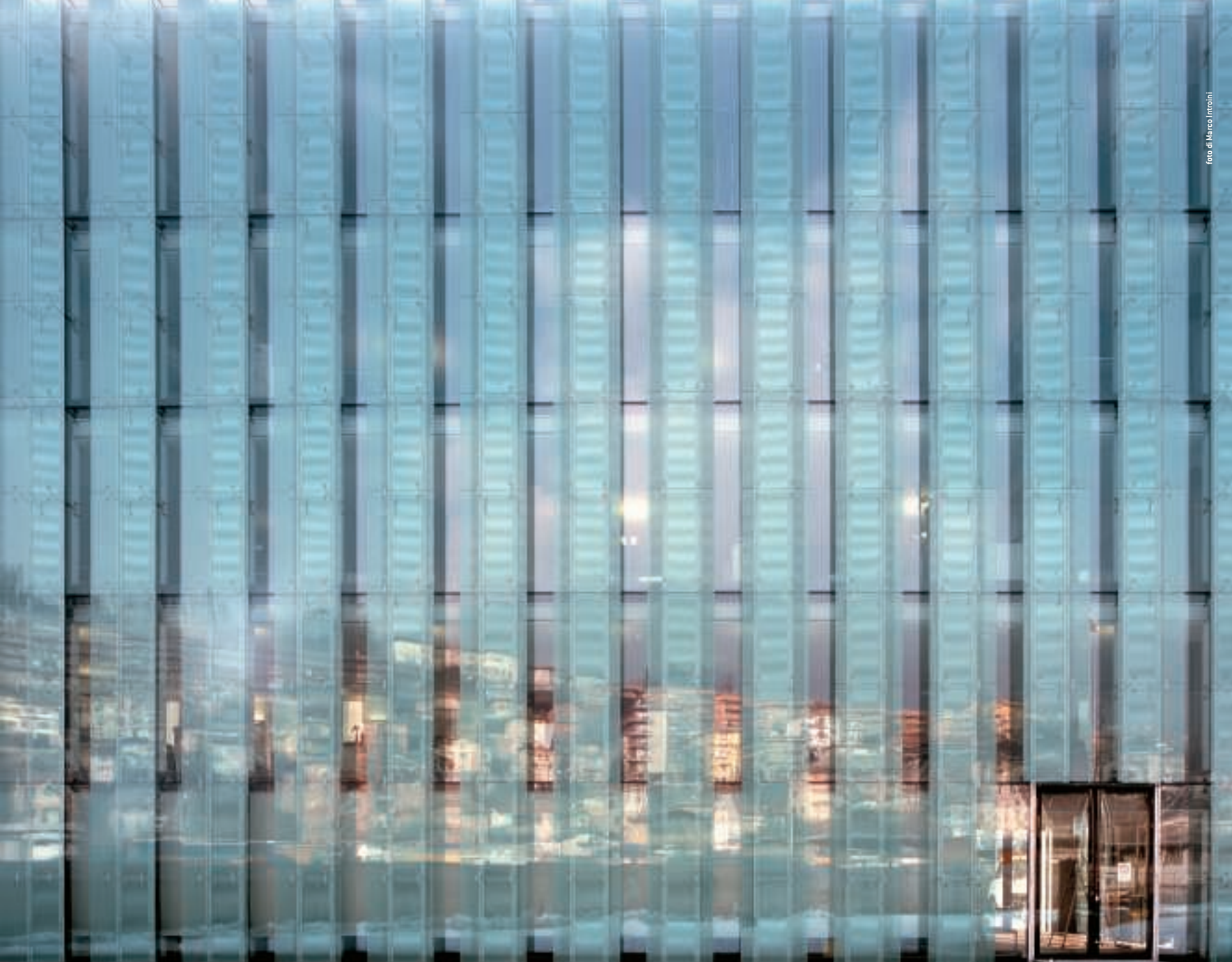
Vista dell'edificio da nord con in evidenza l'alternanza delle fasce serigrafate per il controllo solare
