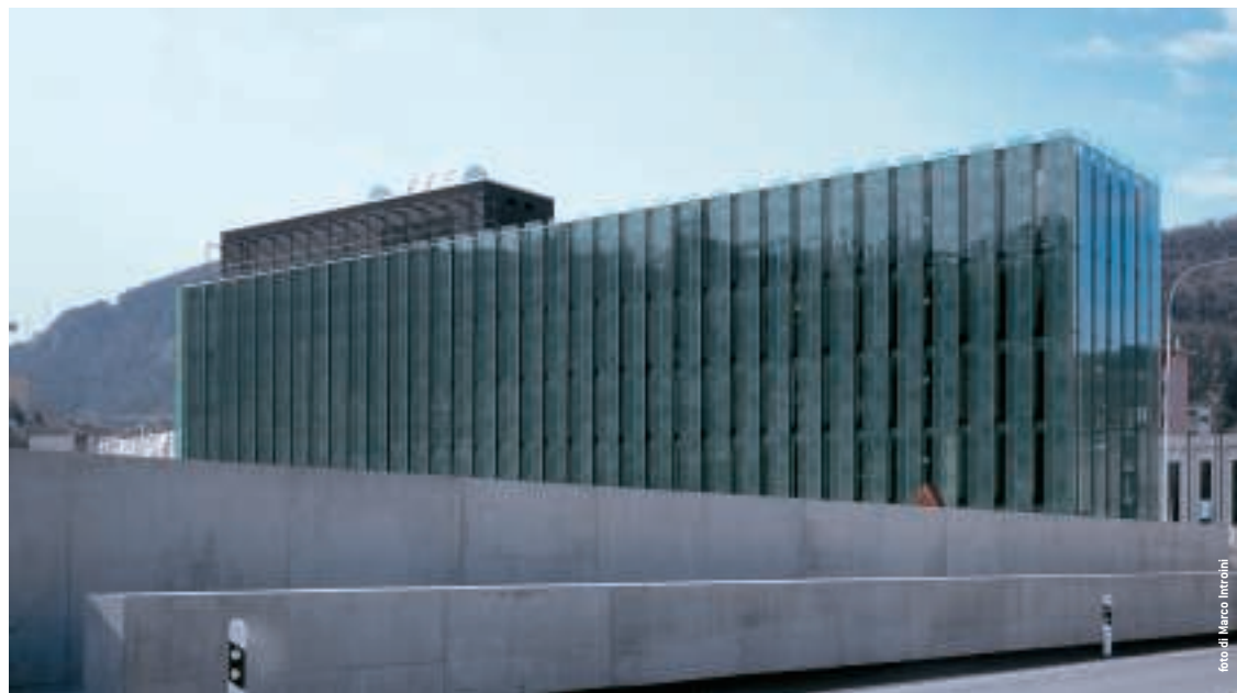
Vista dell'edificio e delle opere di sistemazione esterna da nord ovest
