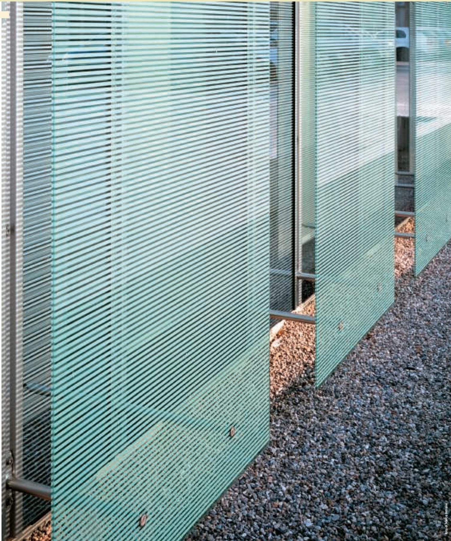
Sistema di controllo solare: vista esterna dell'attacco a terra
