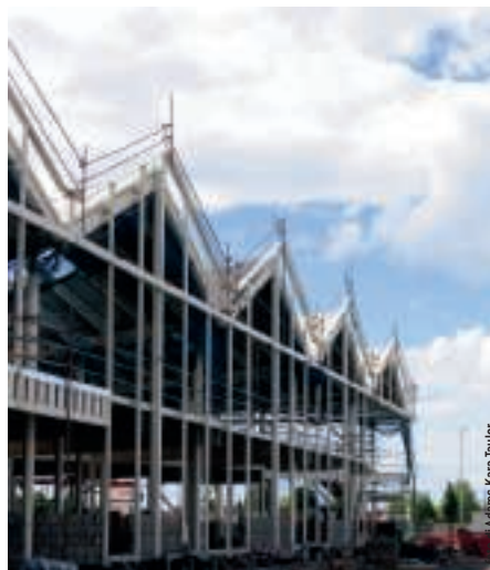
Costruzione della facciata nord-ovest: in evidenza la struttura metallica
