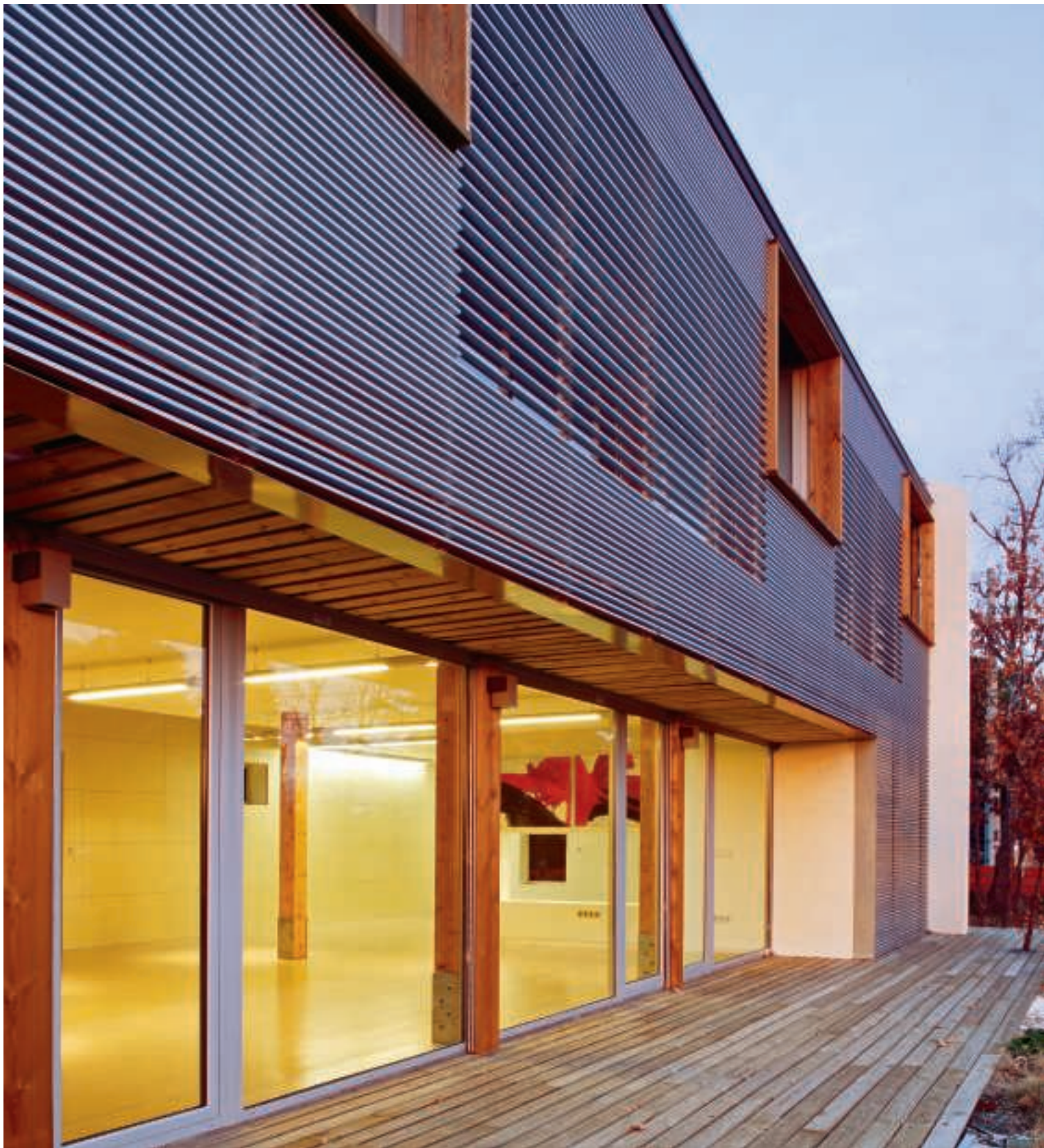
Vista del fronte sud
